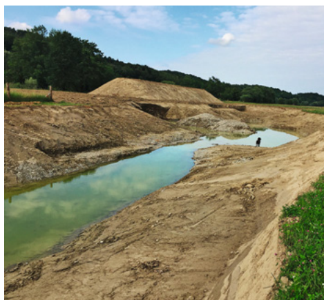
Fertiggestellter Giessen, im Hintergrund eine der Brutwände. Foto: Ruedi Lengweiler
