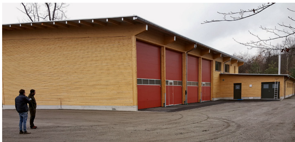
Der gefällige Neubau im Rüteli-Wald der Bürgergemeinde Weinfelden hinter der KVA – dank vorausschauender Planung erbaut zu 80% mit Schweizer Holz aus dem eigenen Forstrevier! Foto: Erich Tiefenbacher
