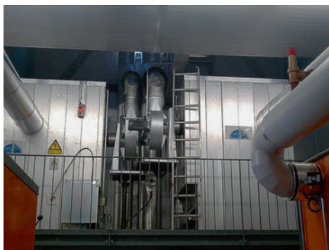
Die beiden Elektro-Partikelabscheider sorgen dafür, dass die Grenzwerte der Luftreinhalteverordnung zuverlässig eingehalten werden.
