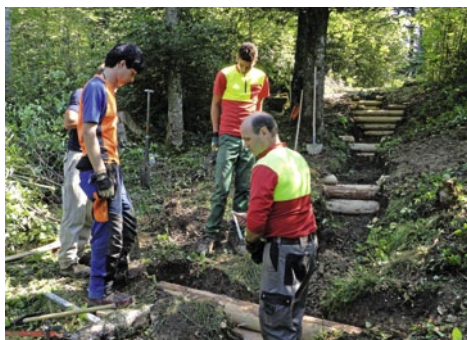
Zur Sicherung der Bachsohle wurden Schwellen eingebaut. Foto: Christoph Ammann
