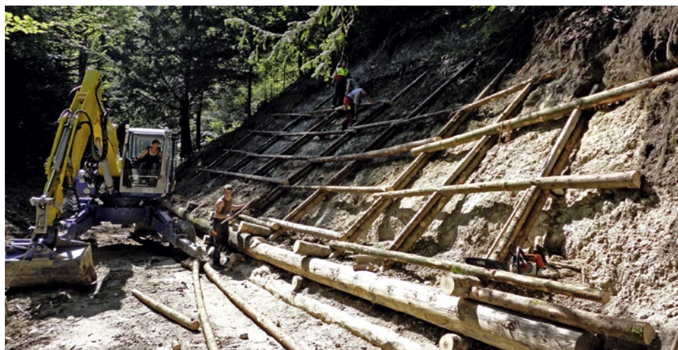
Mit einem Hangrost wurde ein abgerutschter Hang oberhalb einer Strasse gesichert. Foto: Christoph Ammann
