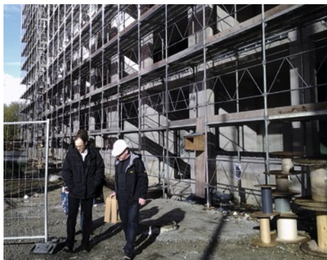
Das Objekt «Sihlbogen»: zwei siebengeschossige Mehrfamilienhäuser in Mischbauweise, wobei unter anderem die Aussenwänden in Massivholz gebaut werden. Foto: Paul Koch
