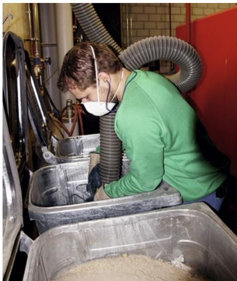
Filter- und Rostasche (Holzasche, die beim Verbrennen durch den Rost fällt) werden separat abgesaugt.
