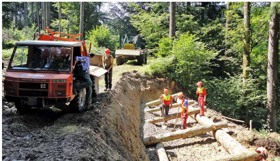
Eine abgerutschte Waldstrasse wurde von den Lernenden mit dem Einbau eines Holzkastens wieder instand gestellt. Das benötigte Rundholz dafür wurde vor Ort gefällt und bereitgestellt. Foto: Christoph Ammann
