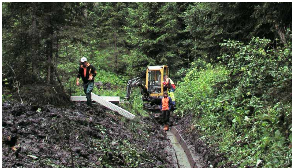
Die Forstwartlernenden beim Ersetzen alter Holzkännel einer Oberflächenentwässerung durch neue Aluminiumschalen. Foto: Christian Künzi
