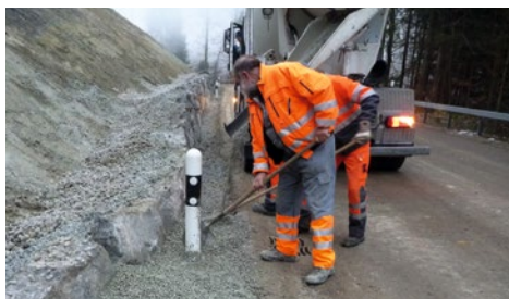
Während der Bauarbeiten. Foto: Joachim Malt
