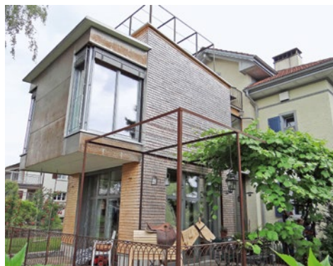
Erneuert und mit Holz erweitert: das Wohnhaus der Familie Müller. Foto: Mathias Rickenbach
