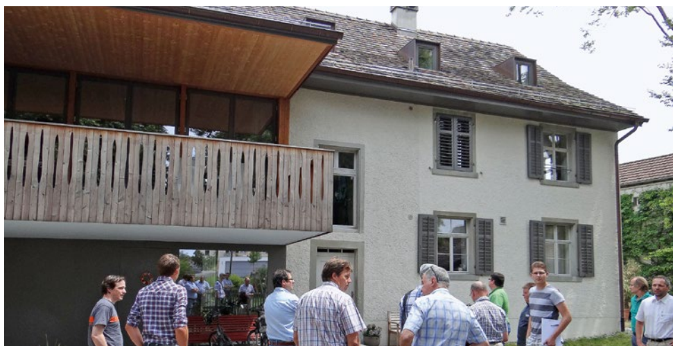
Aus einem alten Wohnhaus mit Scheune baute die Familie Winkler ein modernes Wohngebäude mit viel Holz (Erneuern und Umnutzen). Foto: Mathias Rickenbach
