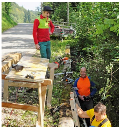
Zur Erhöhung der Sicherheit wurden an zwei Orten entlang von Gemeindestrassen alte Geländer durch neue ersetzt. Foto: Christoph Ammann
