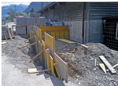
Besonders interessant war das Betonieren einer Mauer für die Gemeinde Seewis. Foto: Yannick Baschung
