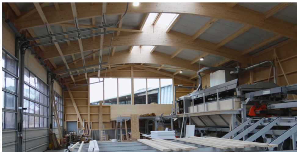
92 Prozent des Holzbedarfes für den Bau der neuen Besäumerhalle der Brühwiler Sägewerk und Fensterholz AG konnten mit Schweizer Holz gedeckt werden. Dafür wurde der Neubau mit dem Herkunftszeichen Schweizer Holz HSH ausgezeichnet. Foto: Claudia Meile
