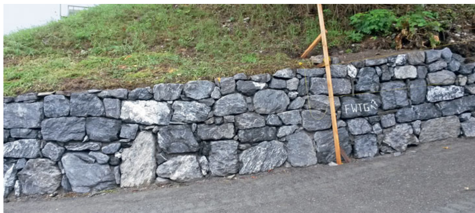
Die Forstwartlernenden ersetzten eine alte Steinmauer durch eine neue, schöne Trockenmauer. Foto: Roger Hollenstein
