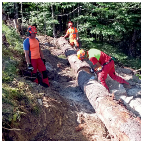
Für eine Ausweichstelle auf einer Maiensäszufahrtsstrasse musste ein Holzkasten errichtet werden. Foto: Roger Hollenstein
